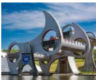
Falkirk Wheel Hebeanlage
